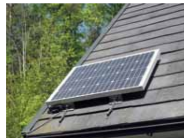
50Wソーラーパネル設置
